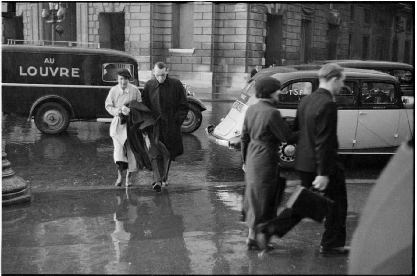
Fotó: Piétons traversant la rue de Rivoli 1930 © André Kertész Médiathèque de l'Architecture & du Patrimoine
